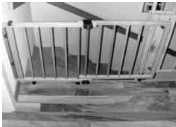
Abb. 2 Gesicherter Treppen- abgang
